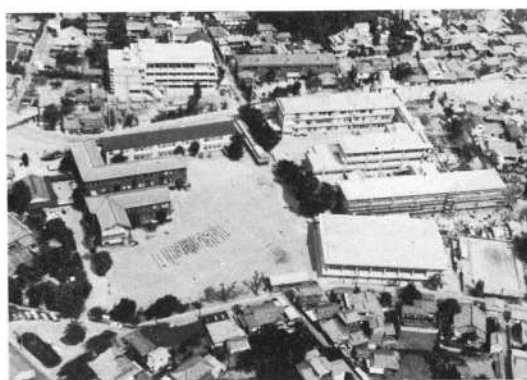
建設途上の全校舎（S.47.9）
