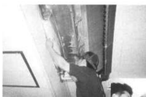
業者によるエアコン クリーニング作業 <写真は作業例>
