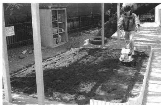
業者による砂場の抗菌作業<写真は作業例>
